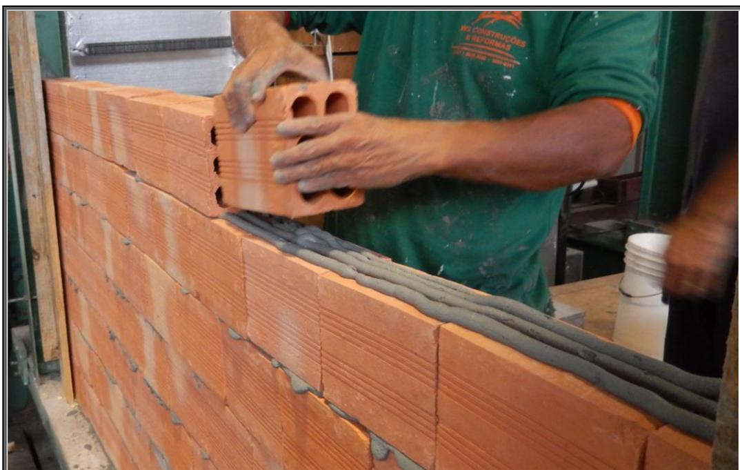
**Figura 3** – Detalhe da conformação dos cordões de argamassa polimérica.
