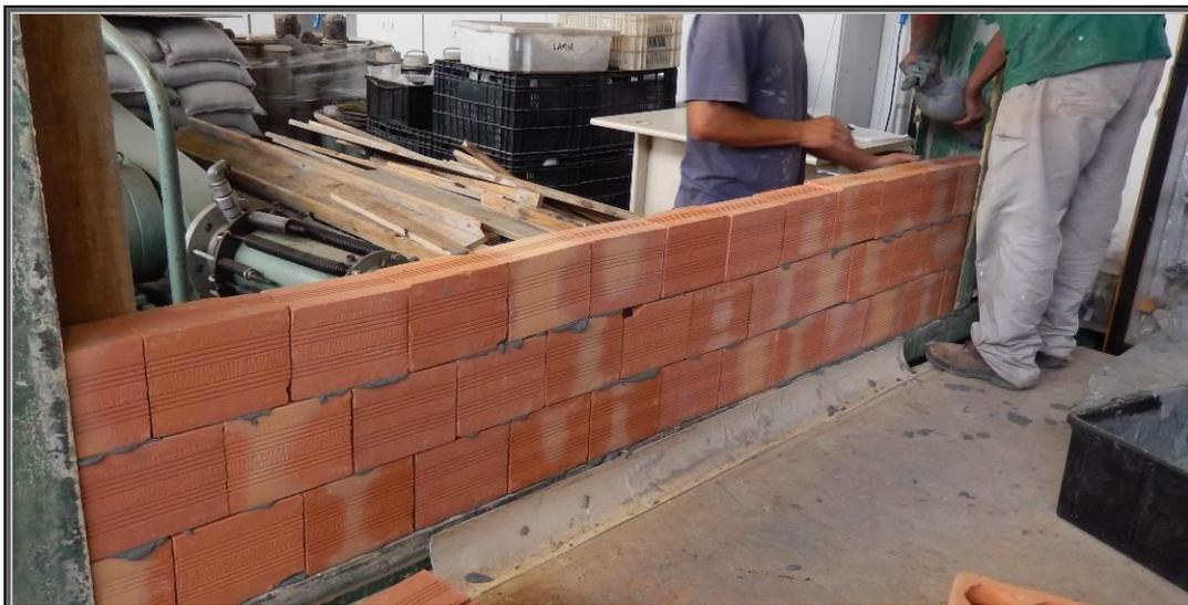
**Figura 2** – Assentamento a partir da segunda fiada com argamassa polimérica Usaforte.
