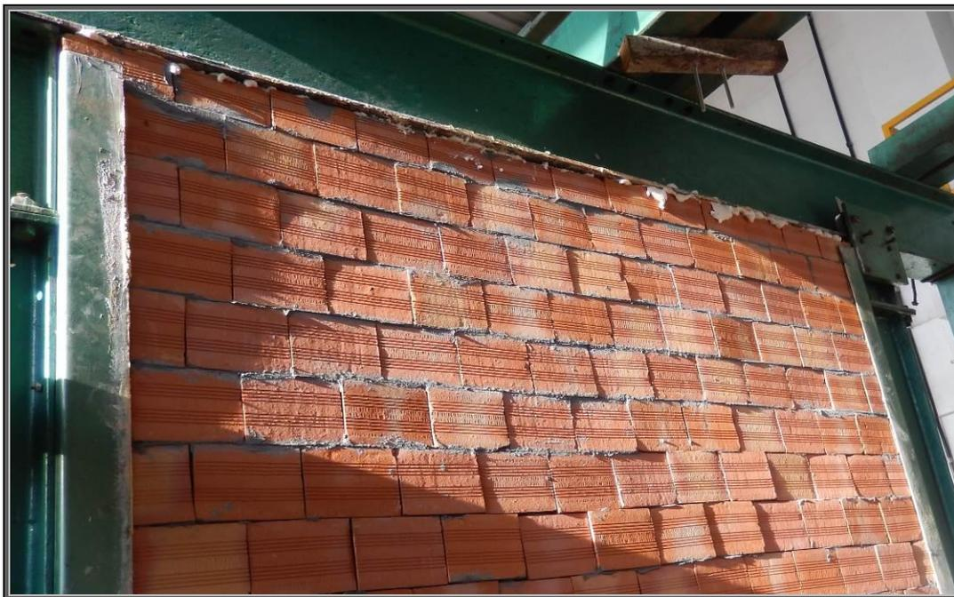
*Figura 5 – Encunhamento executado com espuma expansiva PU.*
